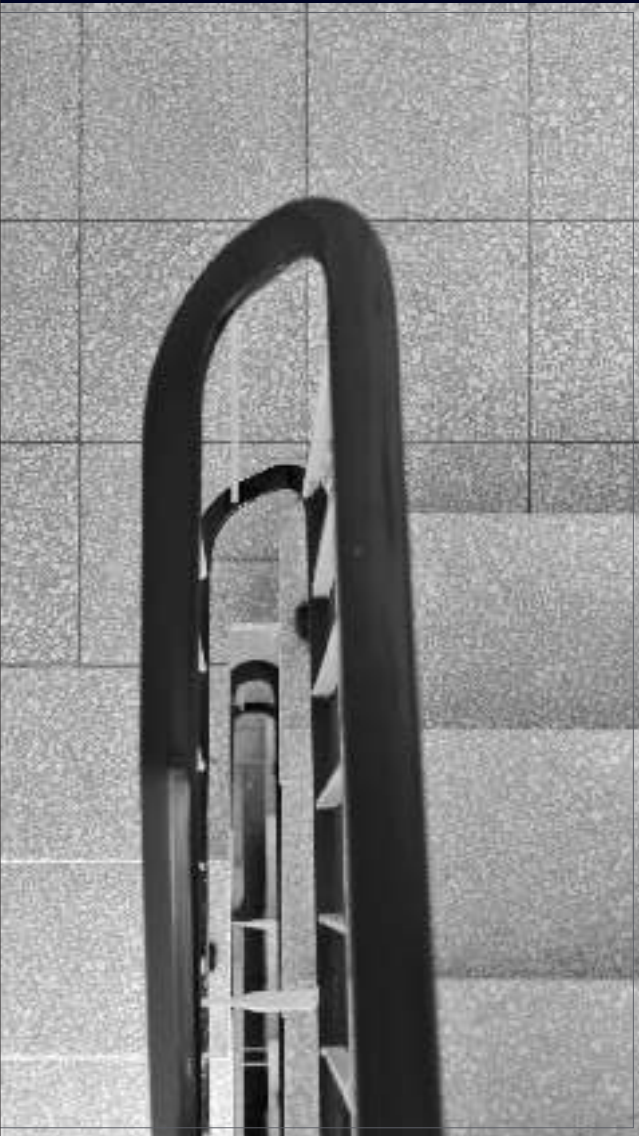
|Außen- und Innenarchitektur (exemplarisch) – Treppenkonstruktion (Treppenaufgang) mit bauzeitlichem, umlaufend gestalteten Stahlgeländer einschl. Handlauf (Seite 28, Abb. oben); perspektivische Aufsicht der mit einem Werksteinbelag versehenen Treppenstufen (Ausschnitt; Seite 28, Abb. unten); Geländerumlauf auf den Podesten (Abb. oben)
